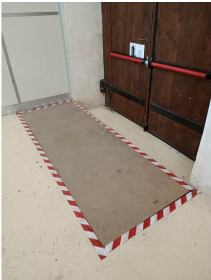
Foto 6.03 - vista dell'ingresso (IP12)
