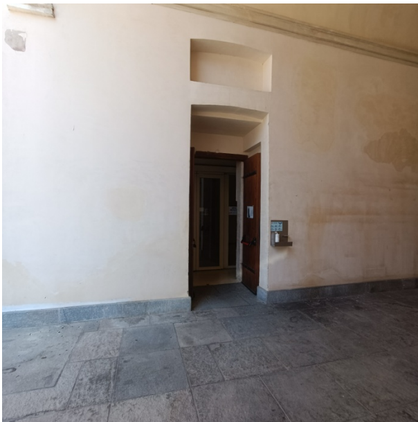
Foto 5.01 - vista dell'ingresso (IP13) alla Manica C
