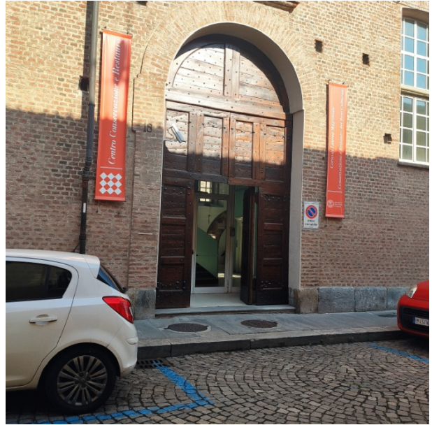
Foto 1.02 - vista ingresso pedonale (IP01) su via XX Settembre
