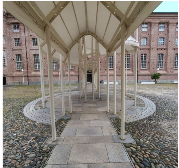
Foto 1.04 - vista passerella di collegamento Cortile
