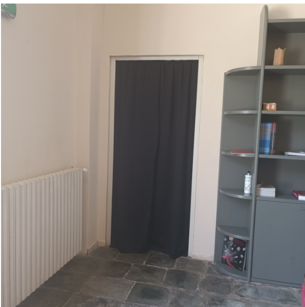
Foto 4.15 - vista del passaggio dal Visitor C. al locale esp. Temp.
