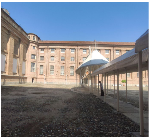
Foto 1.06 - vista cortile interno verso manica A (IP03)
