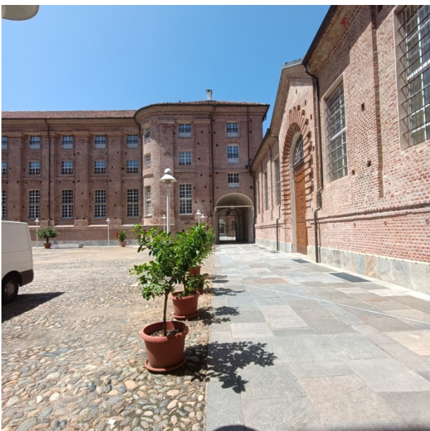
Foto 1.11 - vista del Cortile verso ingresso carraio (IC02)
