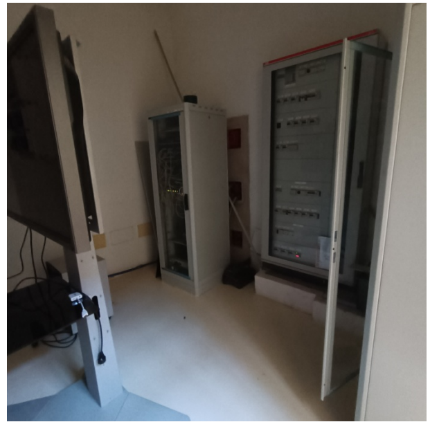
Foto 6.19 -vista locale tecnico
