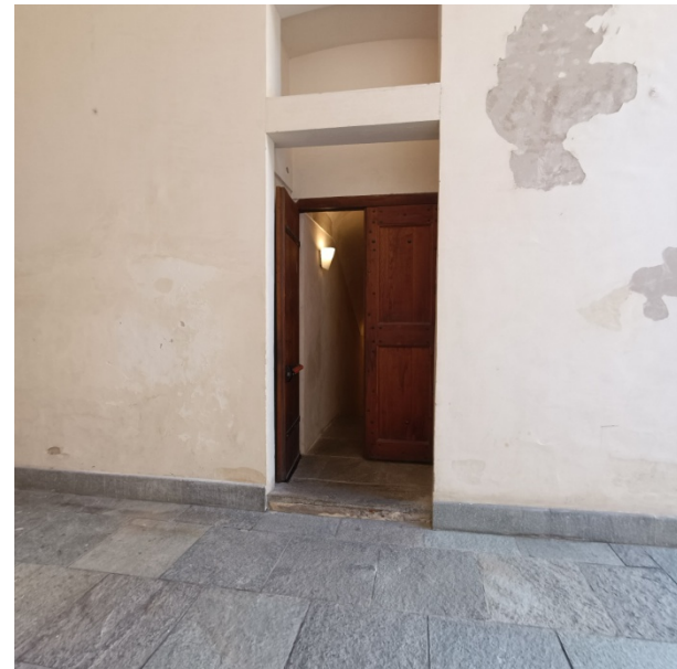
Foto 1.16 - vista dell'accesso IP11 alla scala SC.B.06
