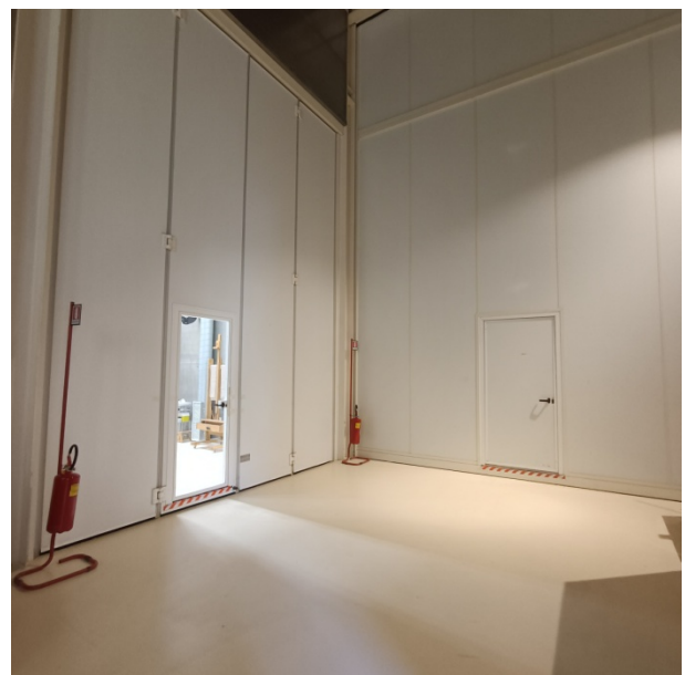
Foto 5.04 - vista del corridoio carroponte
