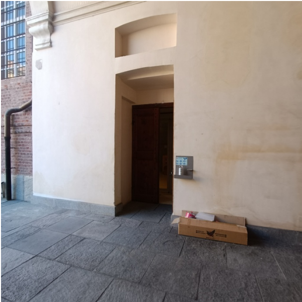
Foto 1.19 - vista dell'accesso IP13 alla manica C
