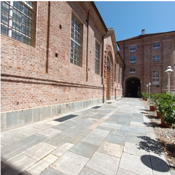
Foto 1.15 - vista del Cortile verso ingresso carraio (IC01)
