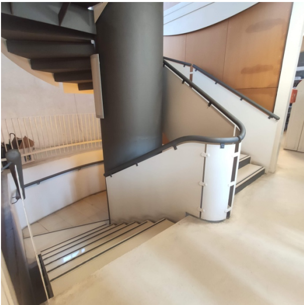
Foto 6.30 -vista scala (SC.B.02) collegamento biblioteca
