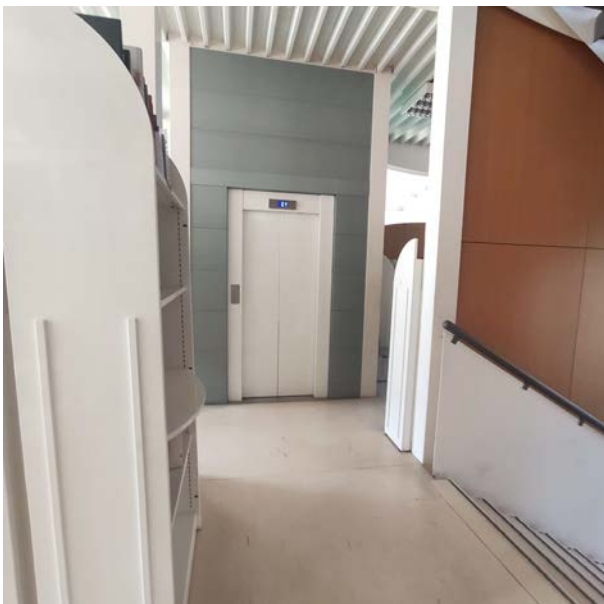
Foto 7.01 – vista del corridoio verso ascensore AS.B.02
