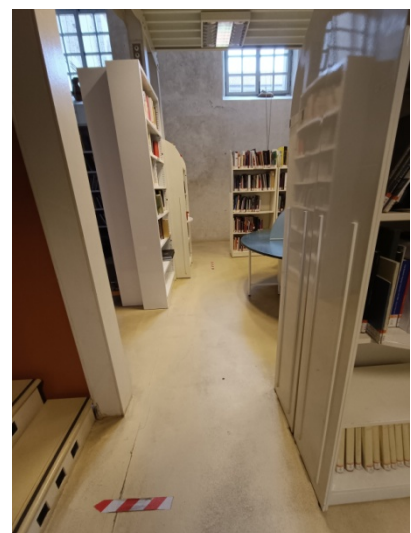
Foto 6.35 - vista corridoio biblioteca
