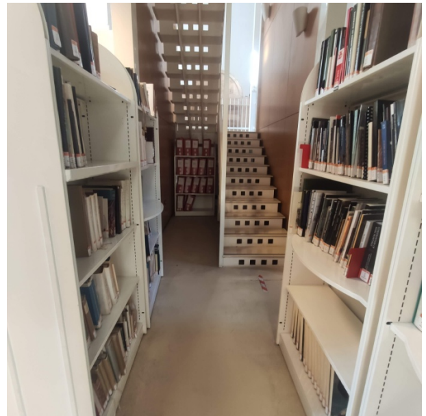
Foto 6.31 - vista scala (SC.B.03) di servizio biblioteca
