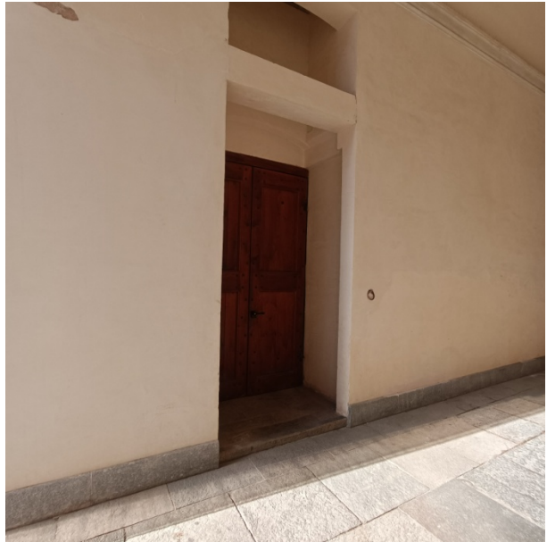
Foto 1.14 - vista dell'accesso IP10 alla scala SC.A.04
