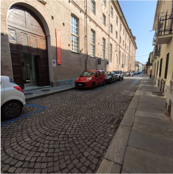
Foto 1.01 - vista Manica B su via XX Settembre
