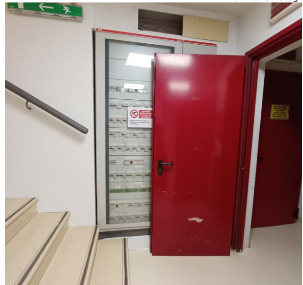
Foto 2.04 -vista verso il locale filtro
