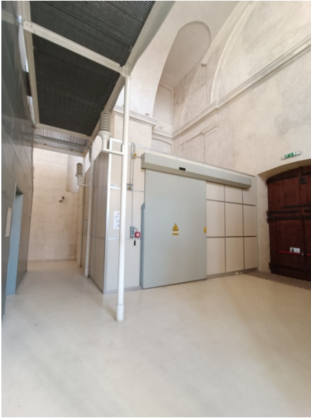
Foto 6.06 - vista area Tac
