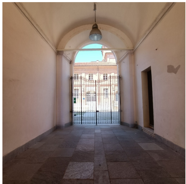
Foto 1.12 - vista dal portico verso ingresso carraio (IC02)
