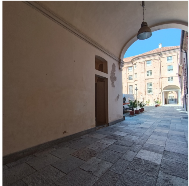
Foto 1.20 - vista del Cortile verso ingresso carraio (IC02)
