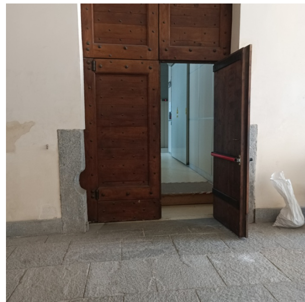
Foto 1.18 - vista dell'accesso IP12 alla manica B
