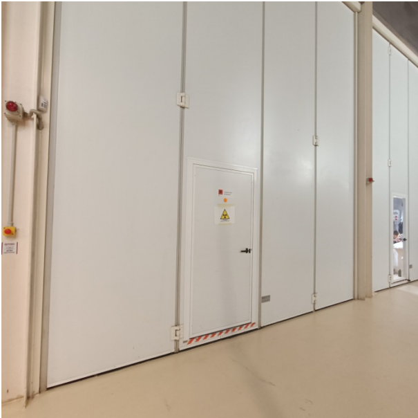
Foto 5.11 - vista delle pareti mobili del laboratorio di fotografia
